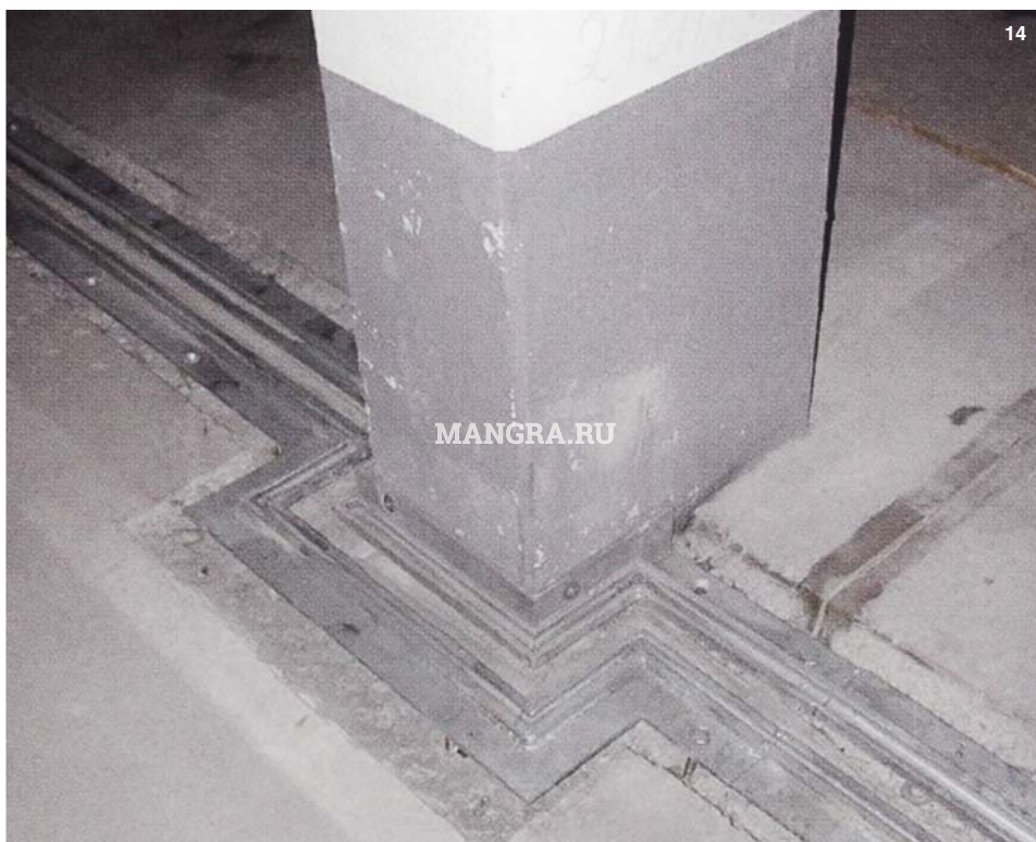
Рис. 14. Стальные профили, установленные в области вертикальной опоры (первоначальное состояние см. на рис. 11)
