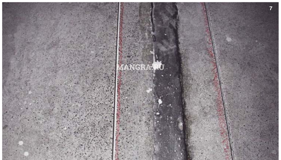
Рис. 7. Начало санации шва, выпилка кромок шва (расчет глубины распила в соответствии с параметрами бетонного покрытия)
