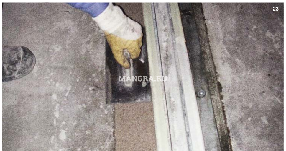
Рис. 23. Шлифовка поверхности затвердевшей эпоксидной смолы, вертикальный распил вдоль видимой кромки профиля для подведения системы защиты
