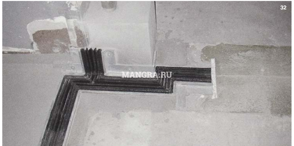
Рис.32. Установленная конструкция деформационного шва в области примыкания «плита пола - стена - трубопровод» (первоначальное состояние см. на рис. 9)
