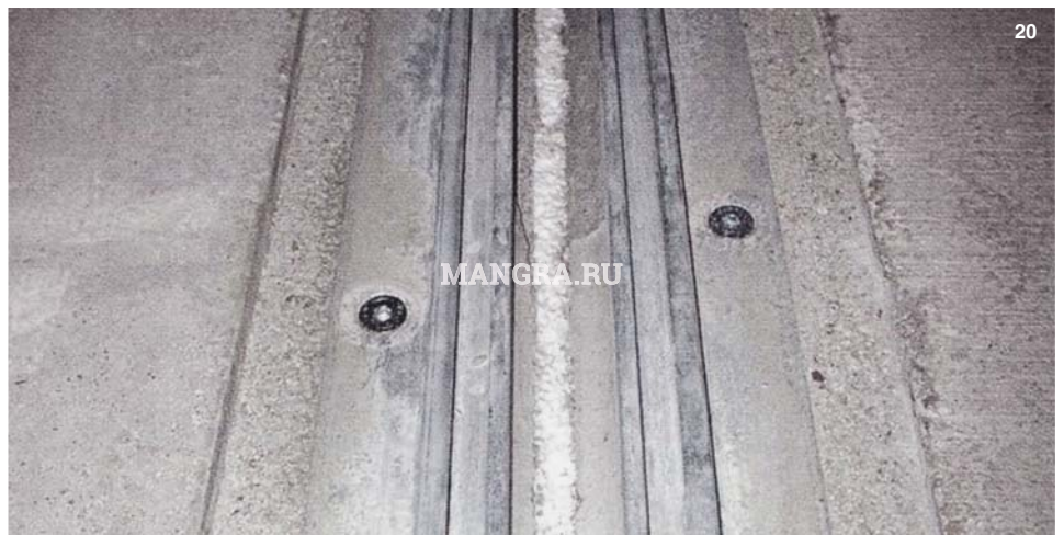
Рис. 20. Залитый цементным раствором угловой профиль после обработки шприц-машиной (забутовка полости шва пенополистиролом)
