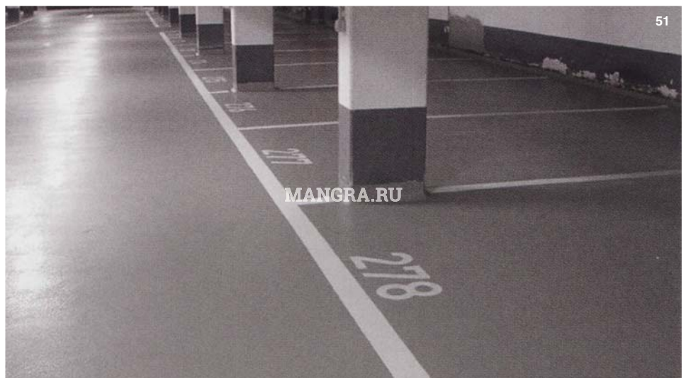
Рис. 51. Подземный паркинг после санации (примечание: заведение защитной системы поверхности на стену - до 150 мм)
