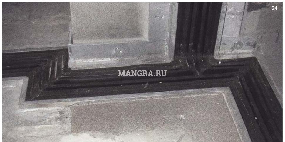
Рис. 34. Область примыкания деформационного шва
