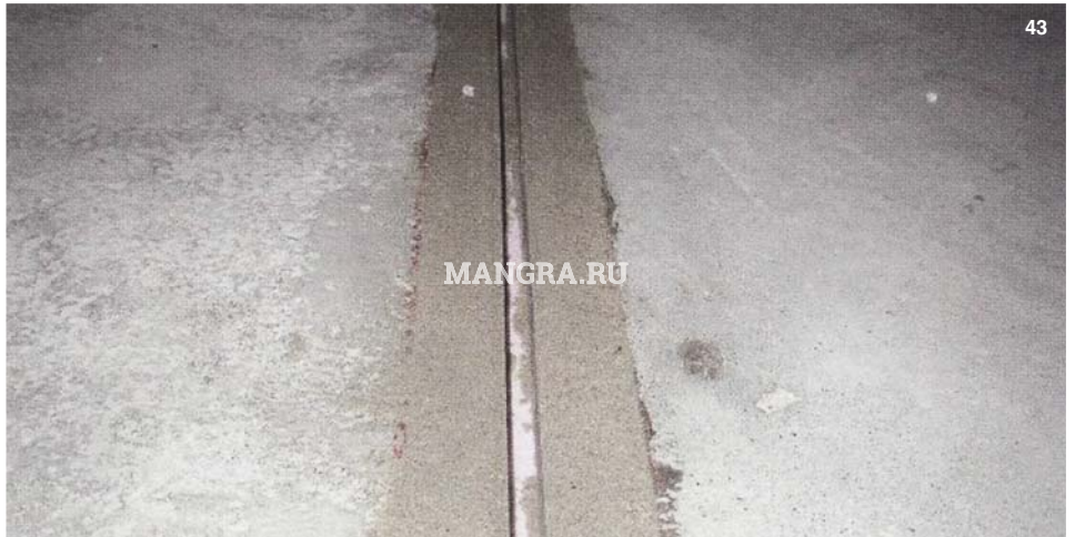
Рис. 43. Состояние шва после восстановления кромок шва раствором эпоксидной смолы
