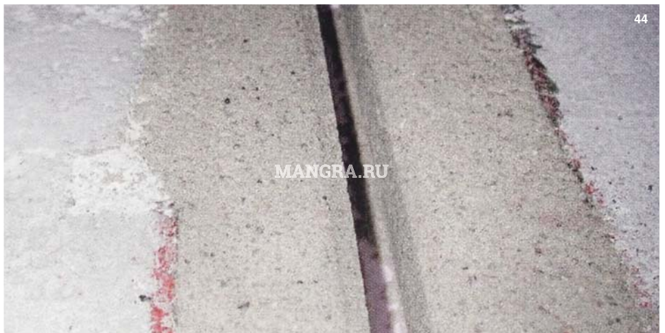
Рис. 44. Кромки шва заведены на рейку и залиты эпоксидной смолой
