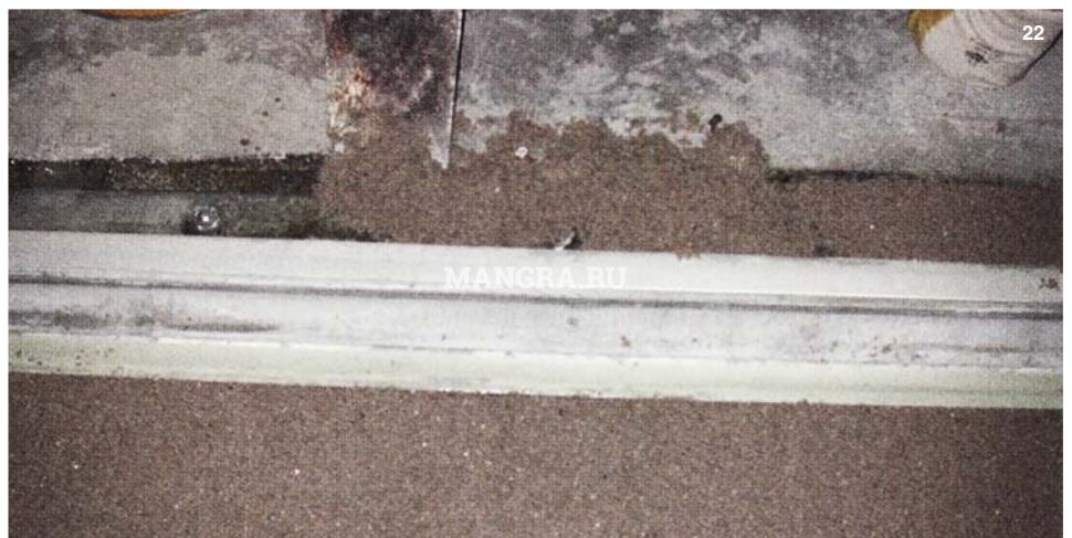
Рис. 22. Нанесение эпоксидной смолы до самых кромок углового профиля
