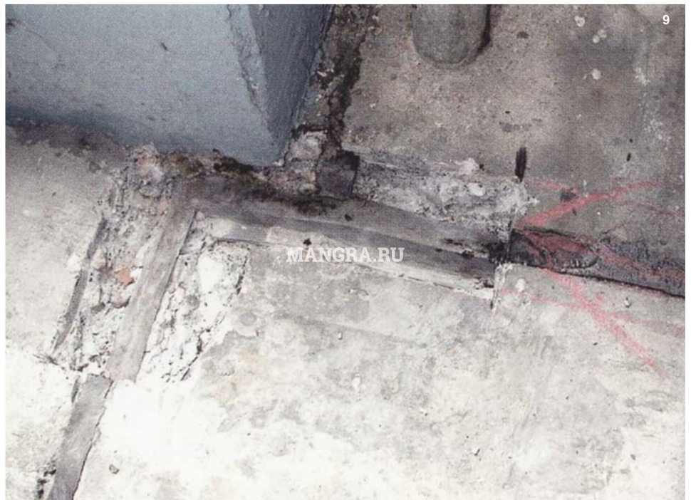
Рис. 9. Обнаженный узел соединения гидрошпонок в области примыкания «плита пола - стена»
