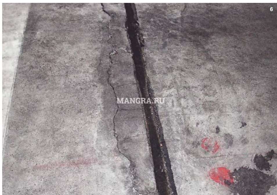
Рис. 6. Неудачная реставрация шва цементным раствором
