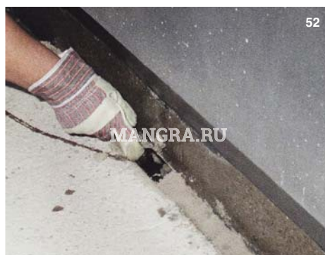
Рис. 52, 53. Галтель из раствора в области стыка горизонтальной и вертикальной поверхности
