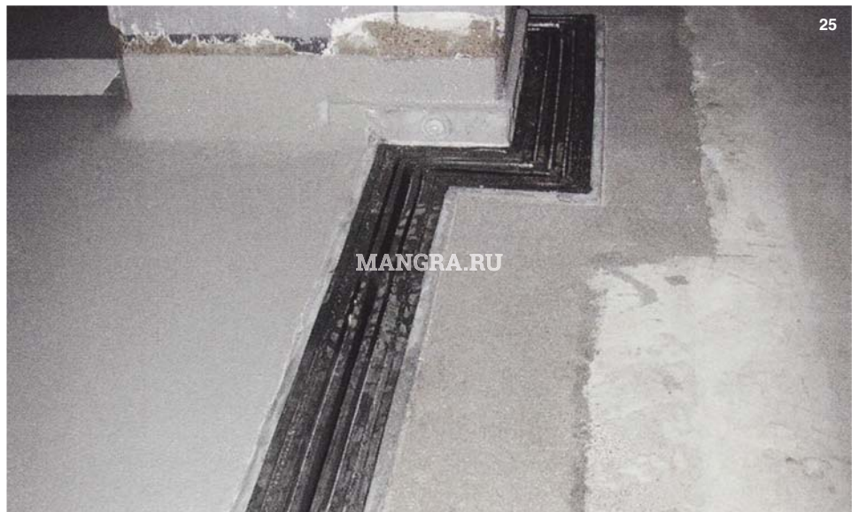
Рис. 25. Состояние деформационного шва при въезде на паркинг после санации (см. рис. 5)
