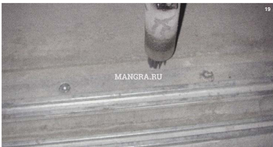
Рис. 19. Обработка поверхности цементного слоя шприц-машиной
