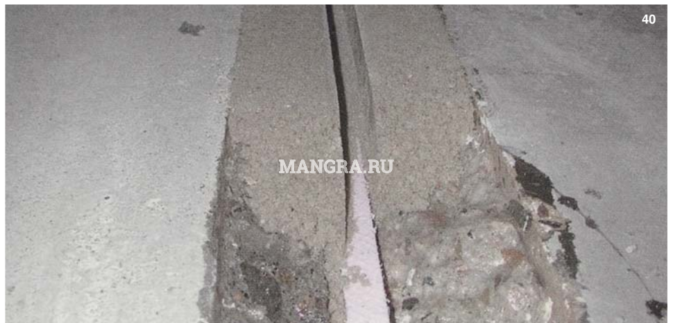
Рис. 40. Грунтовка эпоксидной смолой и нанесение раствора из эпоксидной смолы для восстановления кромок шва (окончательное состояние см. рис. 43)
