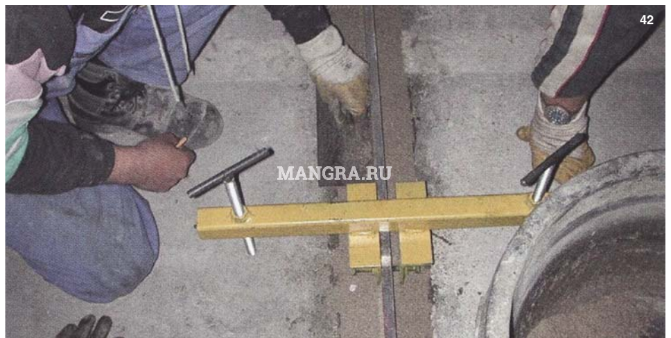
Рис. 42. Инструмент для фиксации рейки под наклоном
