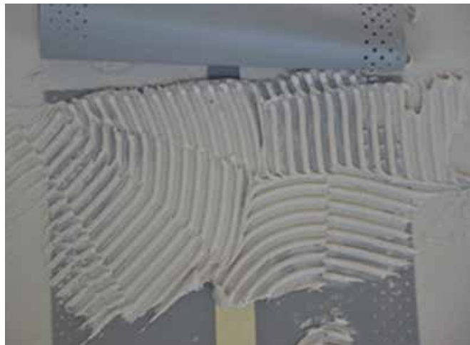
2. Распределите клей по поверхности ленты.
