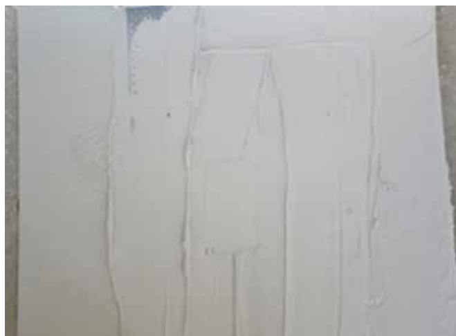
4. Нанесите покрывной слой клея.
