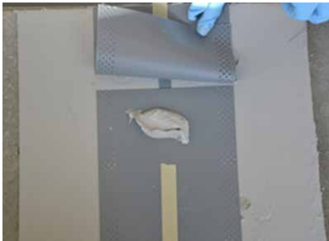
1. Наклест концов ленты должен быть не менее 100 мм.
