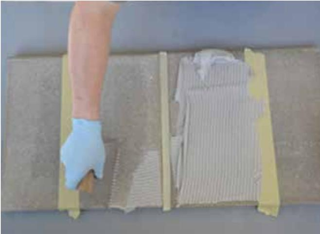
1. Нанесите эпоксидный клей на поверхность. Он должен выступать за края ленты на 2-3 см.
